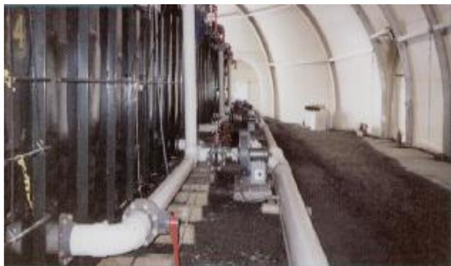
пожарной безопасности. В соответствии с требованиями заказчика могут быть изготовлены конструкции, способные противостоять ветровой нагрузке до 70 м/с. А один из видов мембраны способен выдержать температуру вплоть до -55 градусов по Цельсию. Благодаря своему дизайну конструкция обеспечивает самосброс снега.
