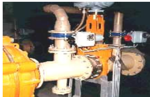
Рис. 5. Внешний вид насоса WARMAN 10/8-FFY с интегрированной системой промывки
