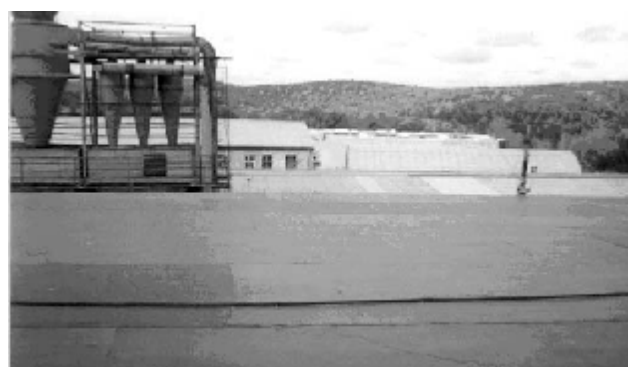
Рис. 1. Гидроизоляция кровли рулонным гидроизоляционным материалом «Р-ПЛАСТ»
