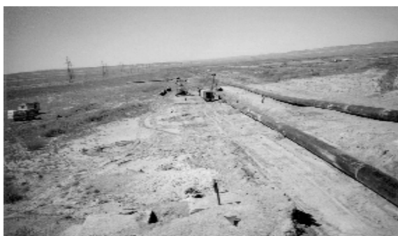
Строительство 3-ей очереди водовода
