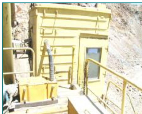
Установка СПГО на экскаваторе
