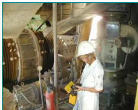
Замеры состава карьерного воздуха в кузове экскаватора
