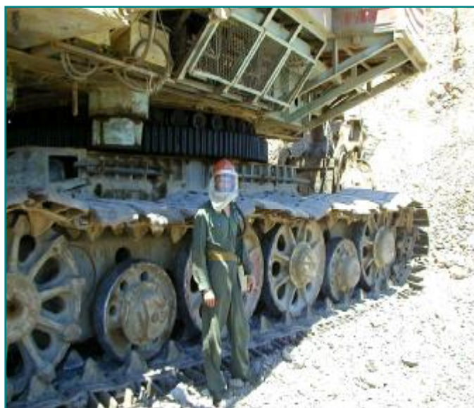
Использование индивидуального средства защиты «Нива» при ремонте ЭКГ
