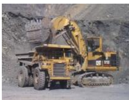
Рис. 4. Гидравлический экскаватор CAT-5230 в забое
