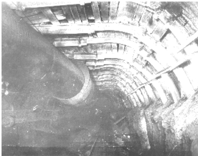
Рис. 3. Бесстоечная крепь в горной выработке
