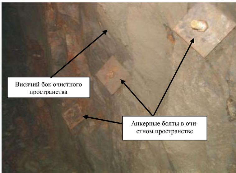
Рис. 3. Крепление вмещающих пород висячего бока в очистном блоке
