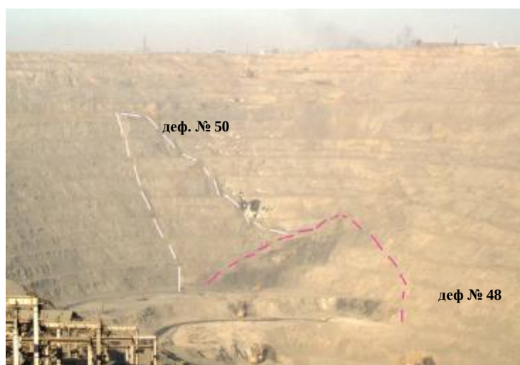
Рис. 7. Расположение деформаций в зоне первой рудной залежи
