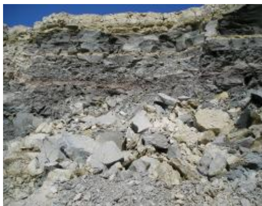
Рис. 9. Вид забоя с непроработанной верхней частью
