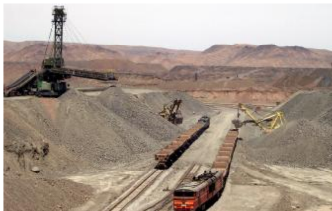
Рис. 2. Отгрузка руды на переработку с конвейерно-экскаваторно-железнодорожного перегрузочного пункта
