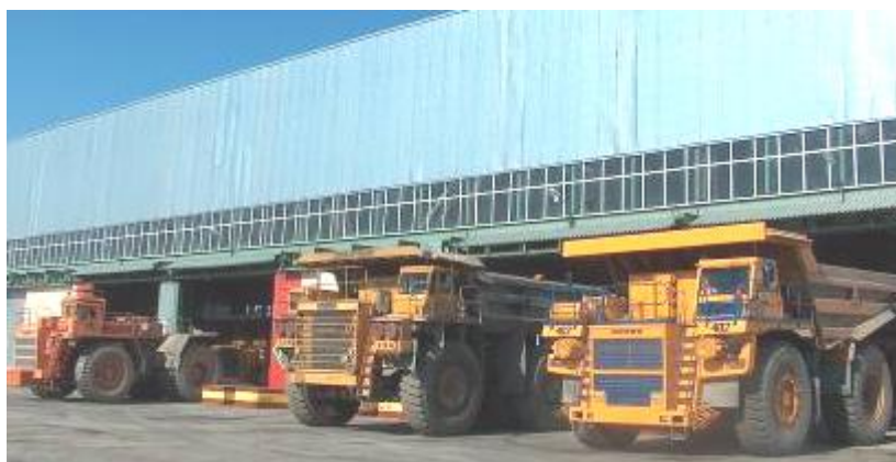
Рис. 1. Новый производственный бокс Управления автотранспорта
