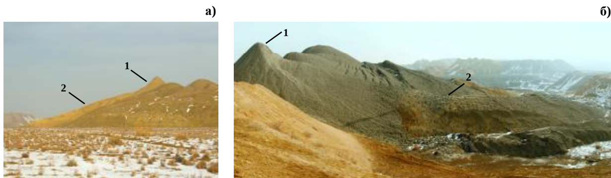
Рис. 3. Примеры формирования техногенных массивов с управляемым развитием деформаций при отсыпке песчано-глинистых пород (а) и мергелистых глин (б) во внешние отвалы: 1 – ненарушенный конусообразный участок массива; 2 – оползневое тело деформации
