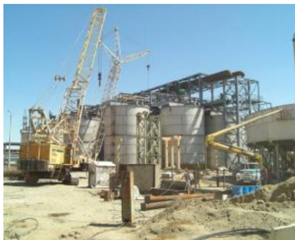
Рис. 1. Строительство установки BIOX® Кокпатаса
