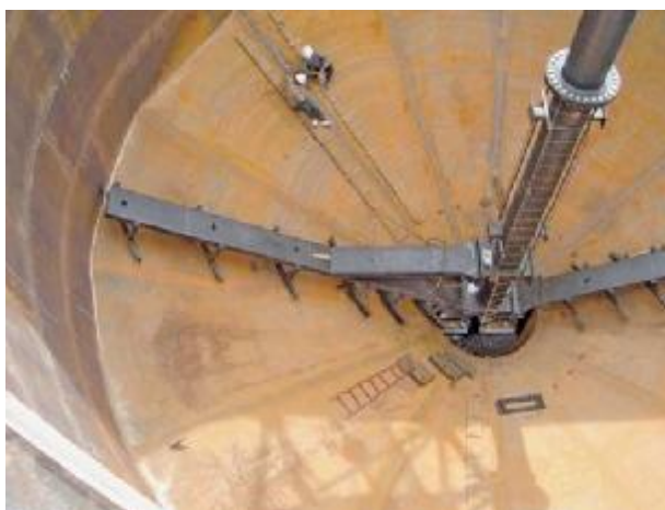
Рис. 4. Пастовый сгуститель во время сборки (высота 16 м)
