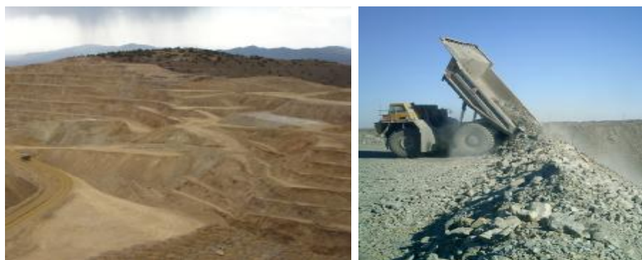
Рис. 2. Вид отвала и разгрузка автосамосвала при площадном отвалообразовании
