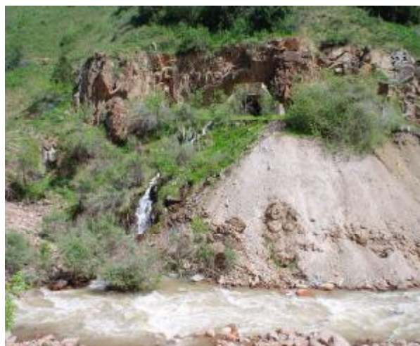
Рис. 2. Дренаж штольни. Отвал размывается рекой. Янгиабадское рудное поле
