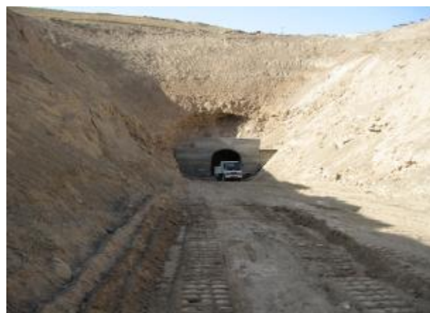
Рис. 4. Стадия строительства портала на въездной траншее наклонного ствола №5-Г на руднике Гужумсай
