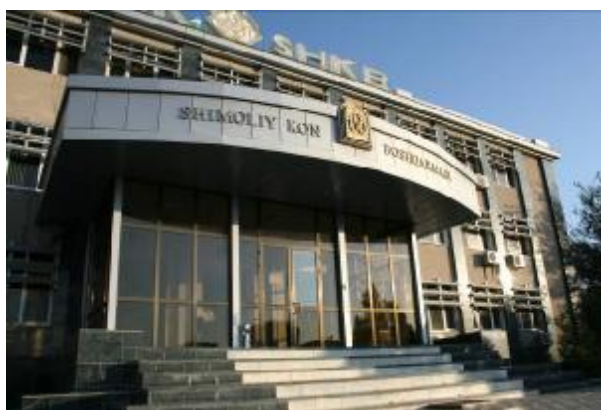
Рис. 2. Здание управления Северного рудоуправления
