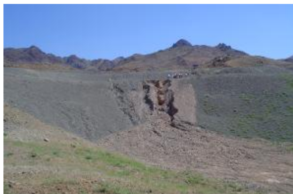
Рис. 10. Размыв хвостохранилища у пос. Адрасман
