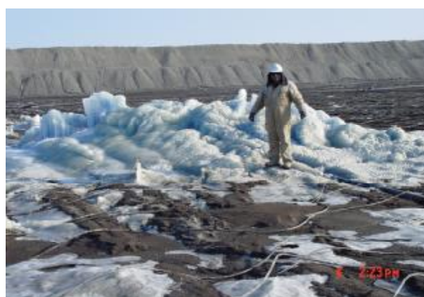
Рис. 4. Торосы из цианистого раствора, образовавшиеся из-за разрыва неэластичных и нетермостойких трубок
