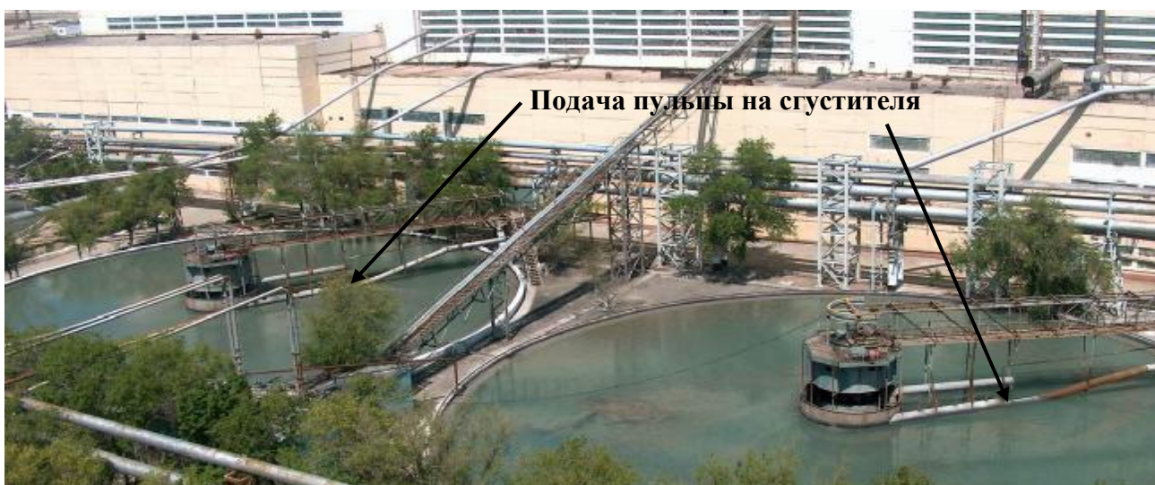
Измененная подача пульпы на сгустителя на ГМЗ-2
