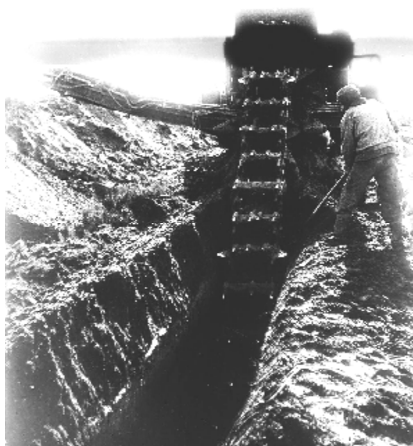
Рис. 1. Проходка зарядной траншеи
