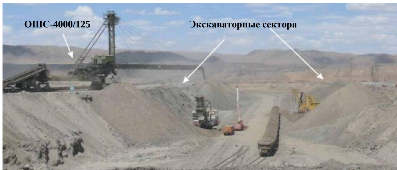
Работа отвалообразователя ОШС-4000/125 на перегрузочном пункте карьера Мурунтау
