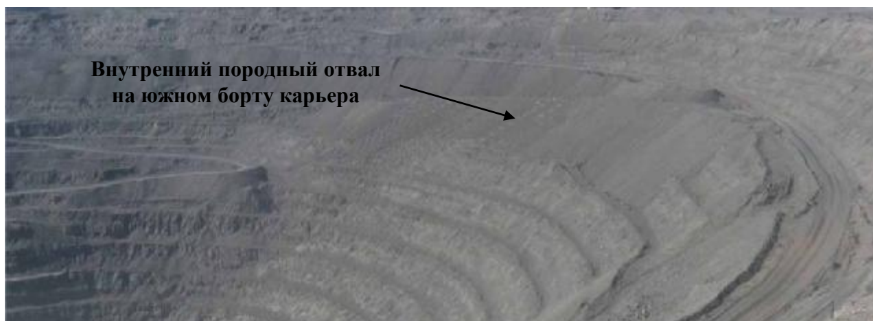
Внутрикарьерное складирование породы на внутреннем отвале карьера Мурунтау
