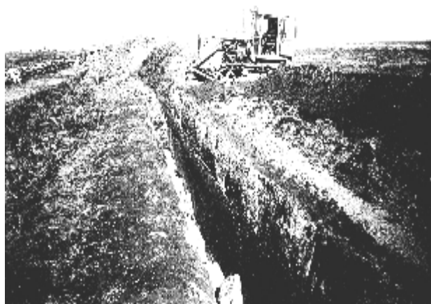
Рис. 3. Зарядка траншеи взрывчатým веществом, забойка и обваловка
