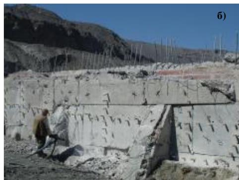
Рис. 4. Подпорная бетонная стенка стационарного ДПУ после демонтажа оборудования (а), бурение шпуров с последующим взрыванием подпорной стенки и циклическим послойным удалением горной породы и разрушенного бетона (б)
