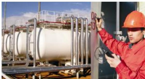
Рис. 2. Проведение НК: измерение толщины стенки сосуда давления
