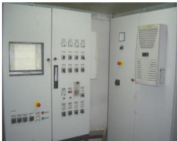
Рис. 2. Шкаф управления и шкаф контроллера в ОП мельника
