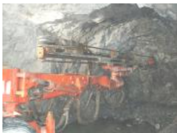
Рис. 3. Проходка наклонного ствола на руднике Зармитан (а), погружно-доставочная машина Scooptram ST-710 (б)
