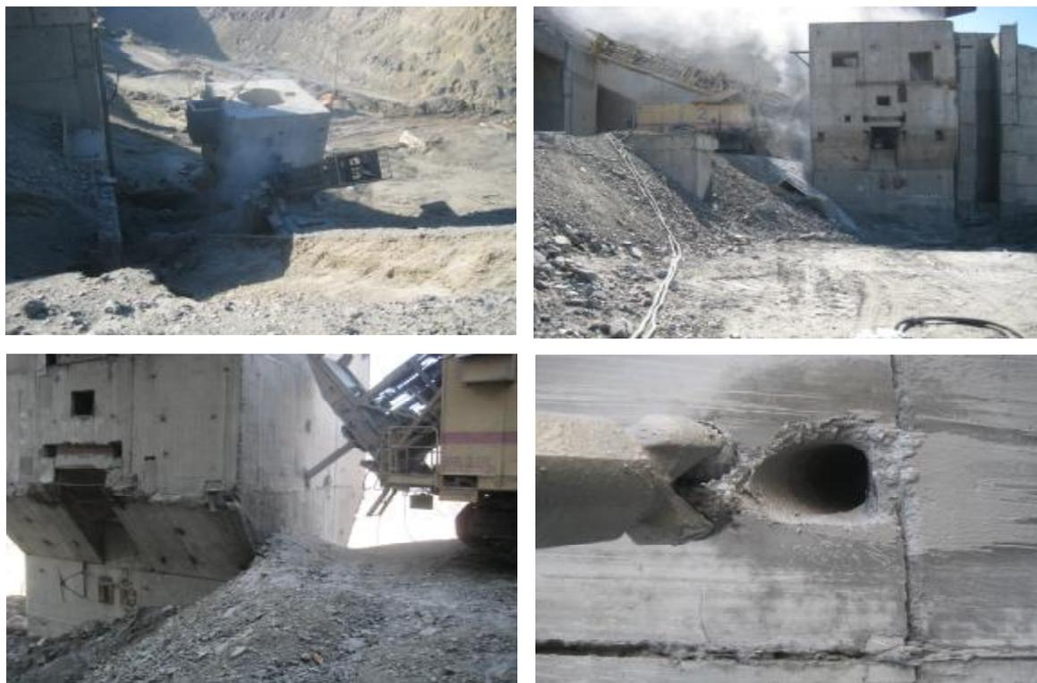
Рис. 3. Обуривание железобетонной конструкции стационарного ДПУ после демонтажа оборудования буровым станком СБШ-250-МН
