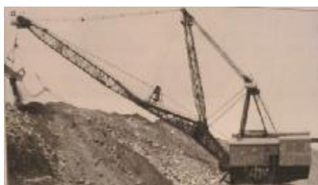
Рис. 10. Драглайн модели 1250 компании «Busyugus-Erie» на вскрышных работах
