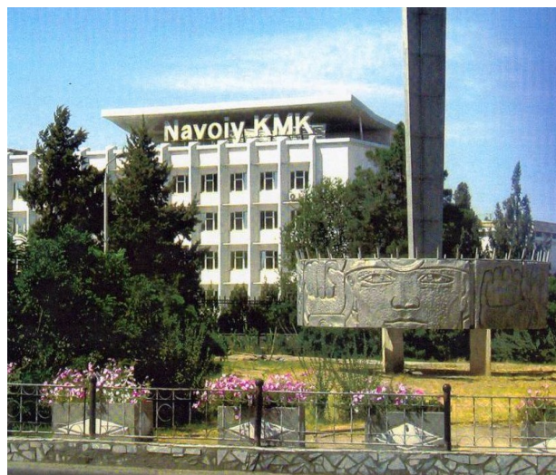
Рис. 1. Здание управления НГМК
