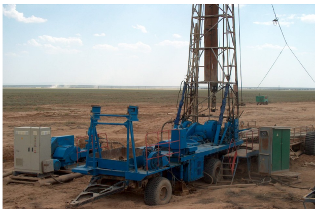
Рис. 2. Первая буровая установка в РУ-5 с электроприводом
