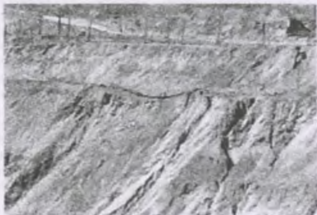
Рис. 1. Оползневая деформация на карьере Сары-Чеку.
