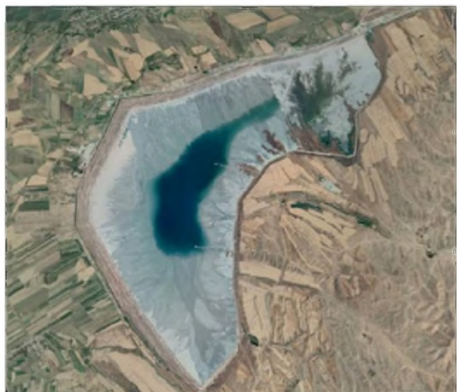
Рис.9. Хвостохранилище № 2 медной фабрики Алмалыкского ГМК
