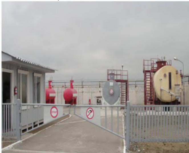
Биогазовая установка птицефермы на 200 м³/сутки.
