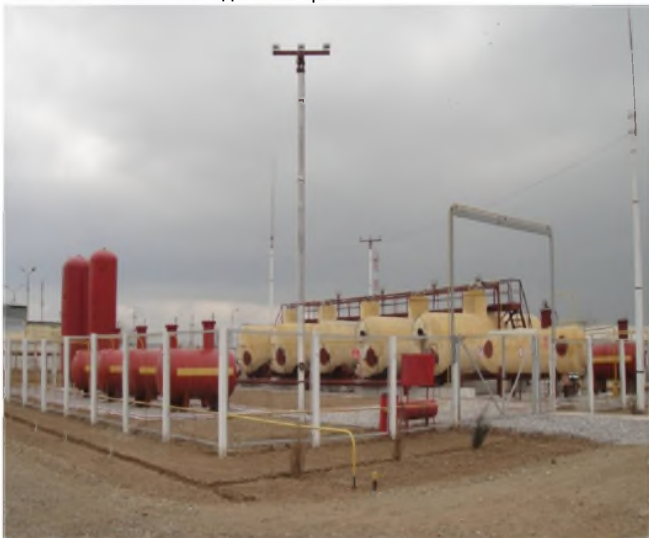
Биогазовая установка МТФ на 600 м³/сутки.
