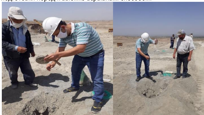
Рис. 3. Измерение глубины скважин глубиномером
