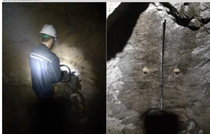
Рис.3. Оборудование с алмазным диском для образования щели
