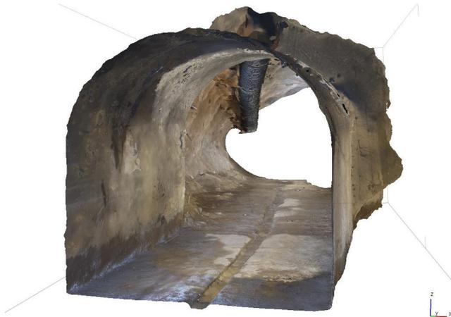
Рис. 6. Финальная пространственная модель подземной горной выработки
