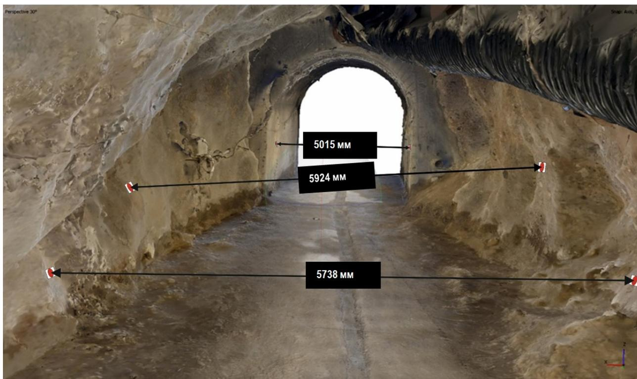
Рис. 7. Проверка пространственного соответствия модели по опорным точкам
